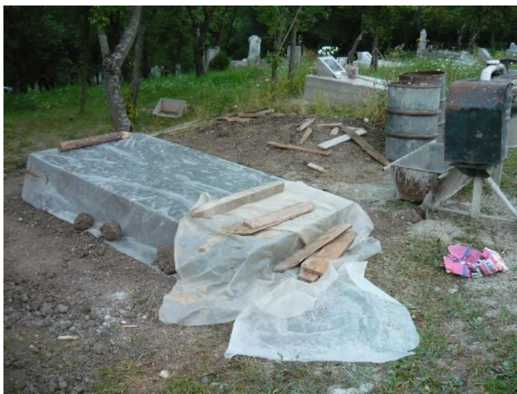
3. kép Kide (Románia): síremlék frissen betonozott alapja a református temetőben – letakarták, hogy védjék az esőtől (saját felvétel, 2013)
